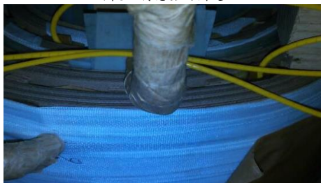
图4 安装在绕组内的传感器
